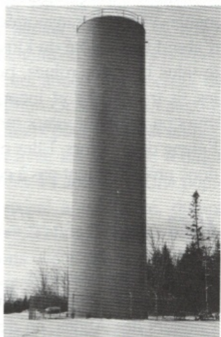
Le réservoir d'eau potable, 3 décembre 1956
