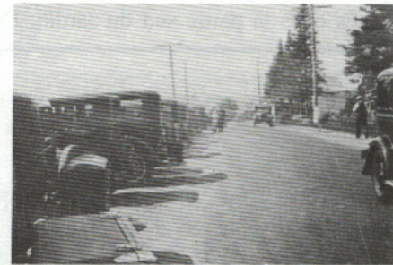
Stationnement le long du mur
